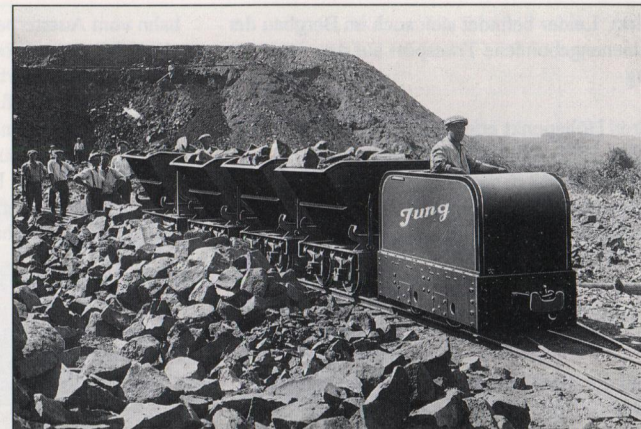
Einsatzbeispiele: 10-PS-JUNG-Diesellokomotive im Steinbruch ...
